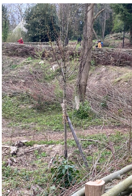
Vue sur les 2 haie sèches achevées – haie clayonnée en tête de talus et ramée de branche en pied de talus
