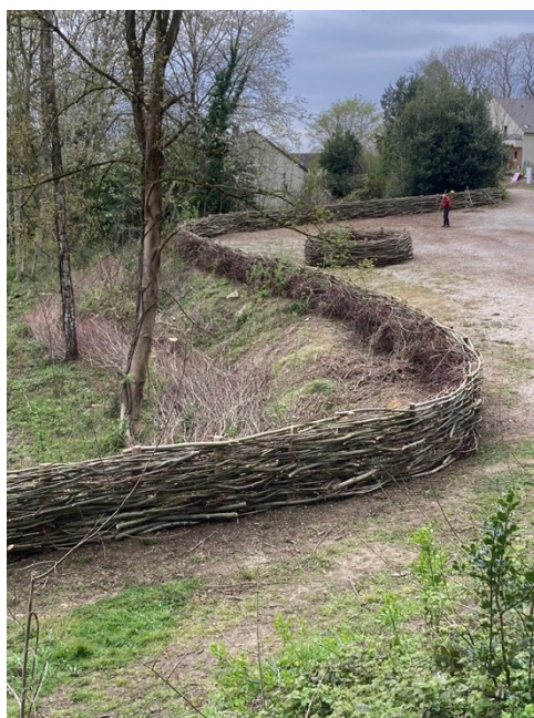
Vue sur les 2 haie sèches achevées – haie clayonnée en tête de talus et ramée de branche en pied de talus
