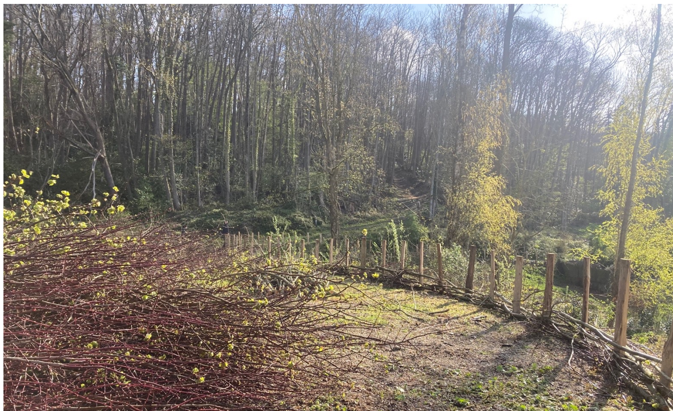
Démarrage du clayonnage
