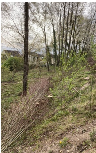
Mise en œuvre de la ramée en pied de talus
