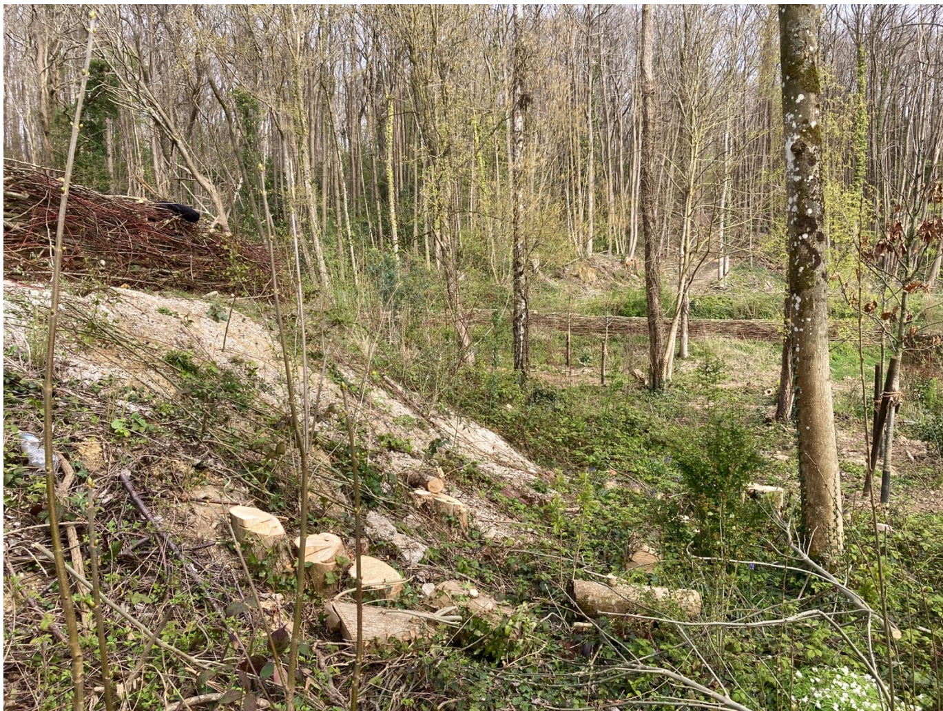
Talus avec souche arasée avant implantation de la ramée en pied de talus
