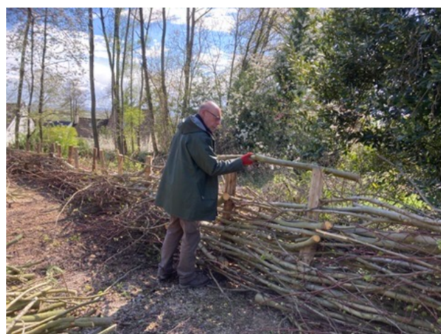
Montage progressif du tressage
