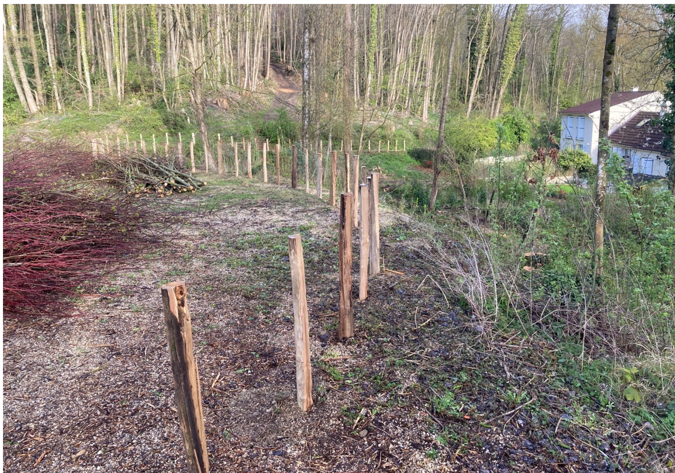
Ligne de piquets avant tressage des branches
